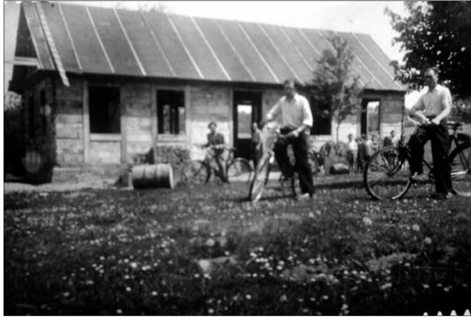
Ryc. 83. Budowa drewnianej szkoły w Podwysokiem na początku lat 50., fot. ze zb. B. Wojtasiuka.
